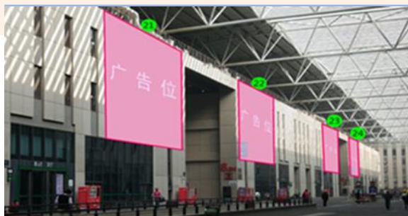
C50 展馆外墙广告 — 二层(16米层)车道 (新)
